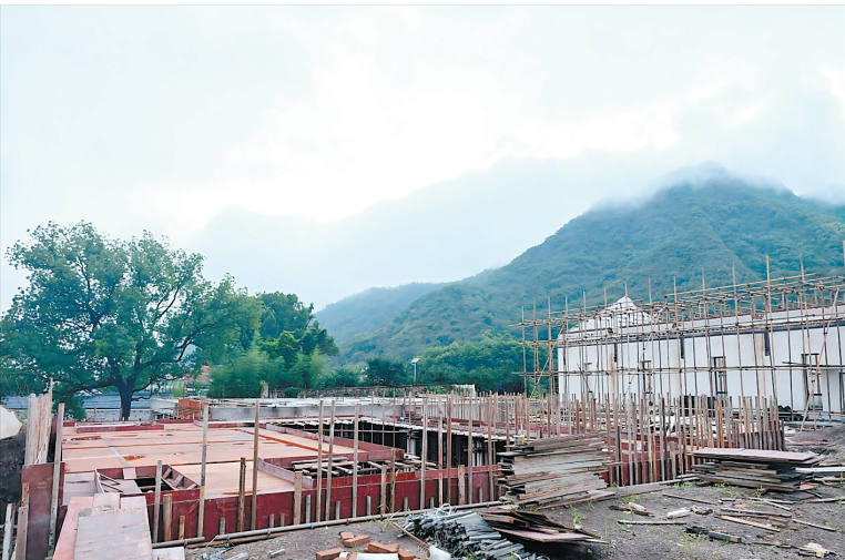
方山柿冷链保鲜仓储中心建设现场
