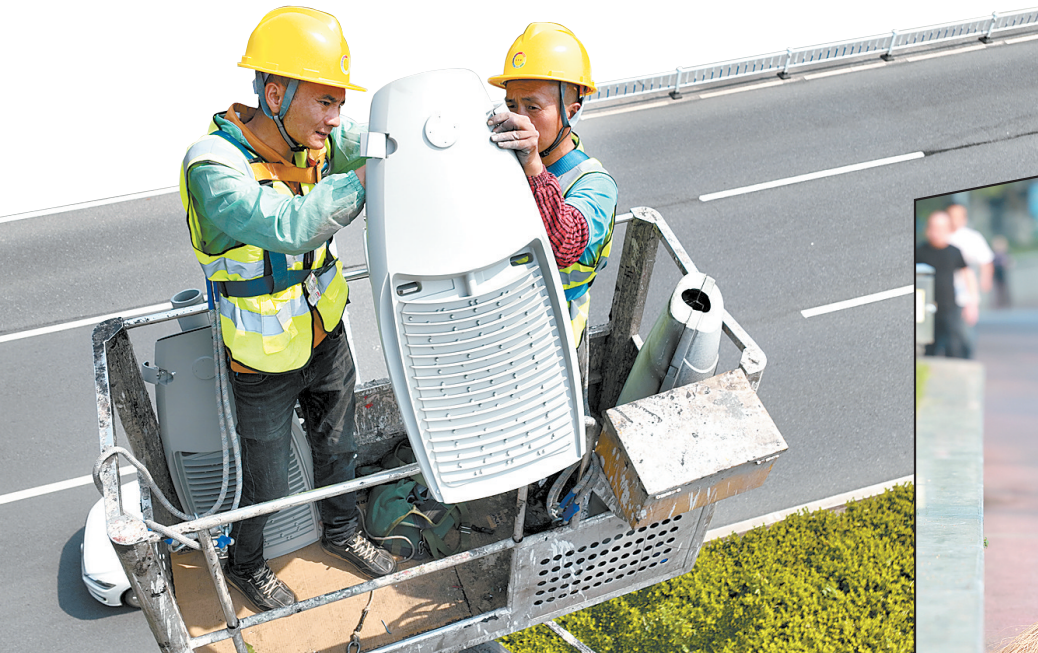
施工人员更换路灯
