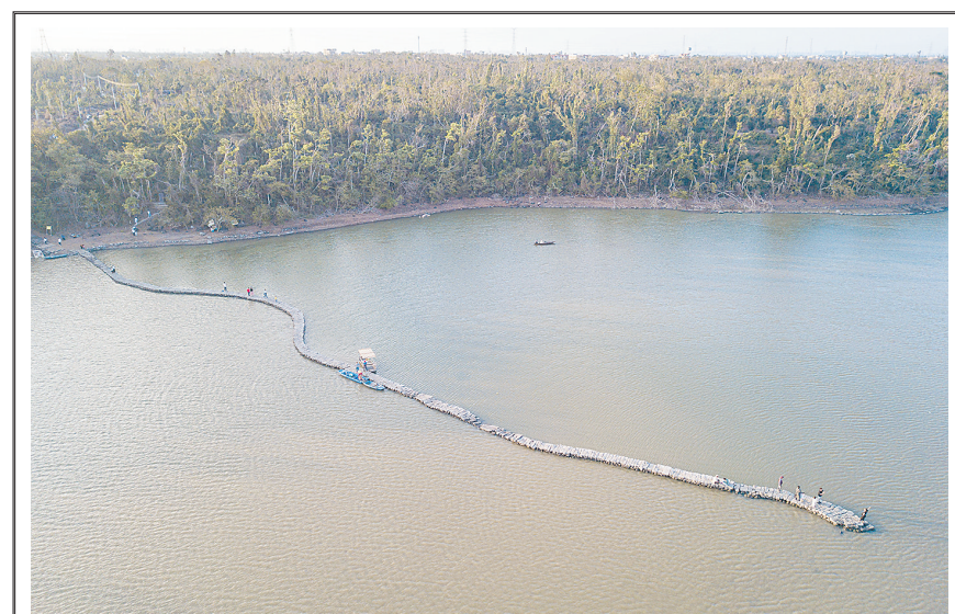
蛇桥 浮春水 踏青正当时 3月1日在海口市琼山区龙塘镇拍摄的 蛇桥(无人机照片)。国仓村石桥位于海口市琼山区龙塘镇美味河畔,是明代名臣丘濬带领当地乡绅民众修建的系列水利工程中的一部分,距今已有500余年历史。其因形似长蛇伏卧河面,又被称为“蛇桥”。石桥由火山石修建,水涨则没,水退则显,一年只在初春至初夏时节浮出水面。 新华社记者 蒲晓旭 摄
