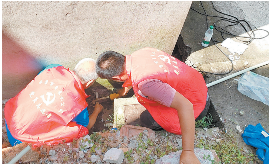
工作人员正在检查供水管线
