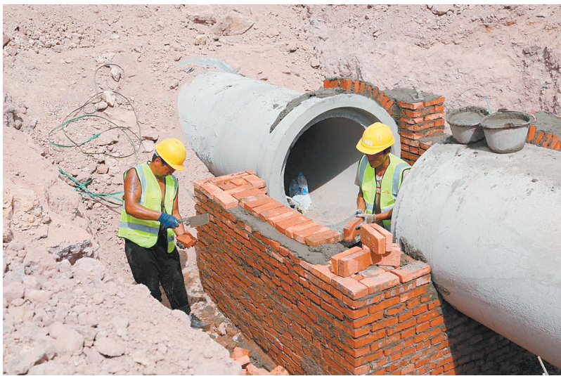
市政工人在砌井
