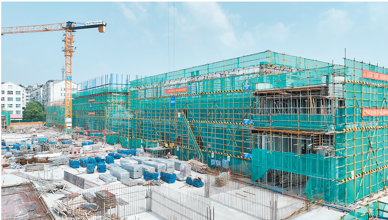
南苑区块安置房项目建设现场
