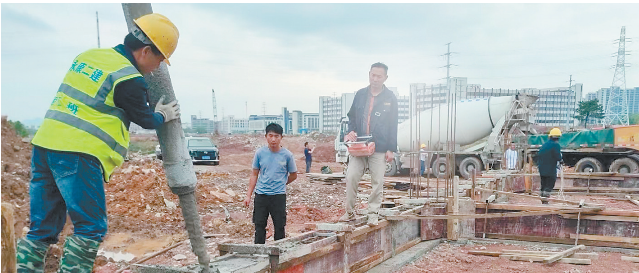
项目施工现场
