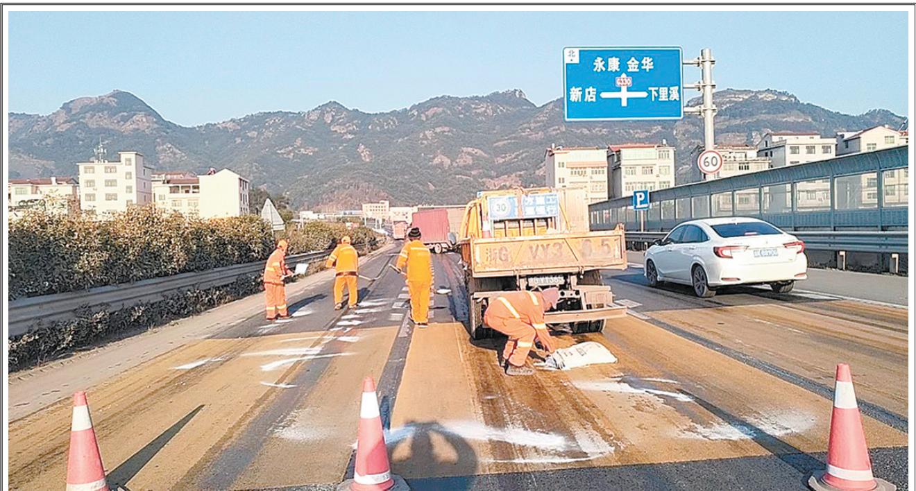
日前,市公路与运输管理中心道路养护人员冒着严寒,在管养路段的桥梁、陡坡、风口等易结冰路段抛洒融雪剂,铲除冰霜,以防路面结冰影响群众出行安全。
