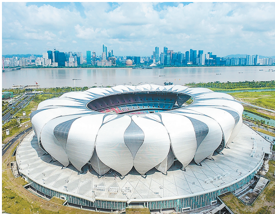
杭州奥体中心体育场
