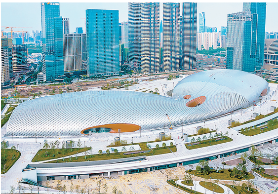
杭州奥体中心
