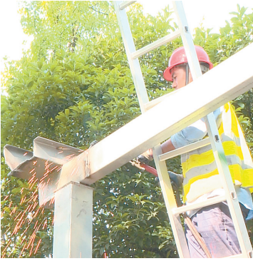
工人切割钢构节点
