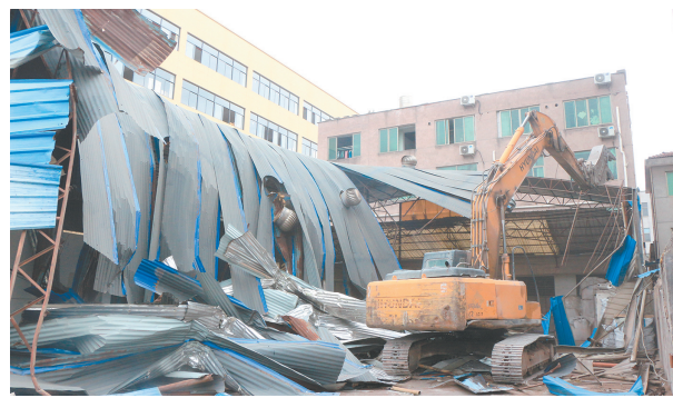
拆除违章建筑
