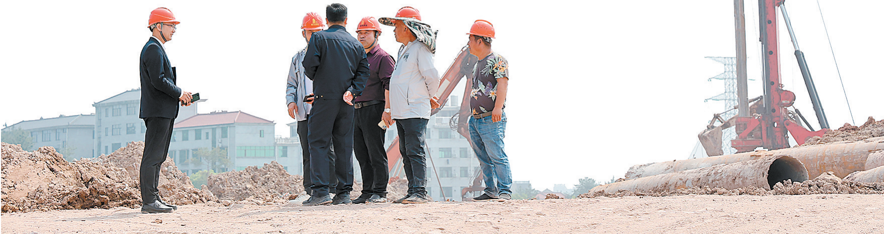
处置工程渣土
