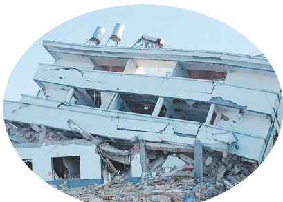
拆除老陶瓷厂区块厂房 融媒记者 潘燕佳
