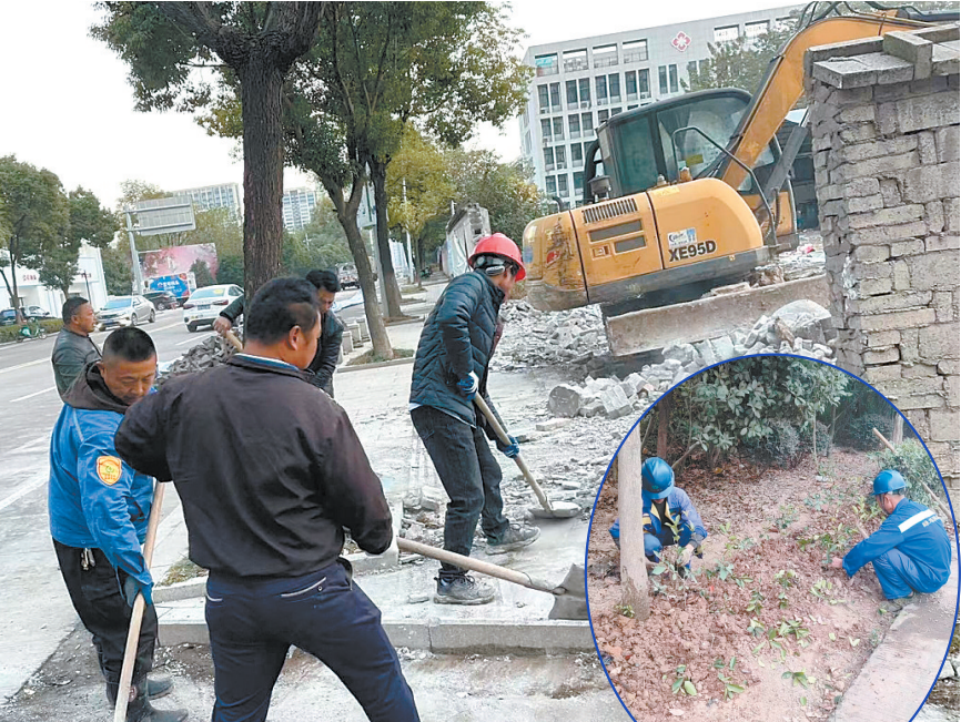
修补倒塌围墙 ►补植绿化
