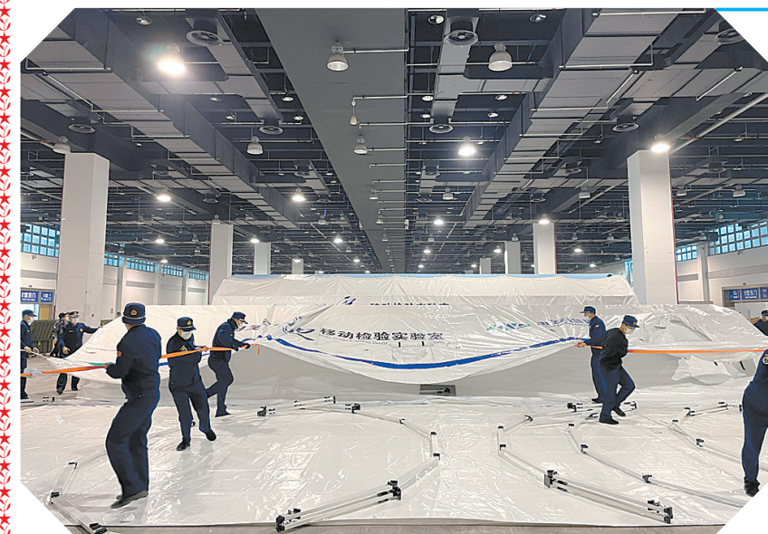
搭建气膜方舱实验室
