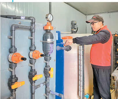
调试加药设备
