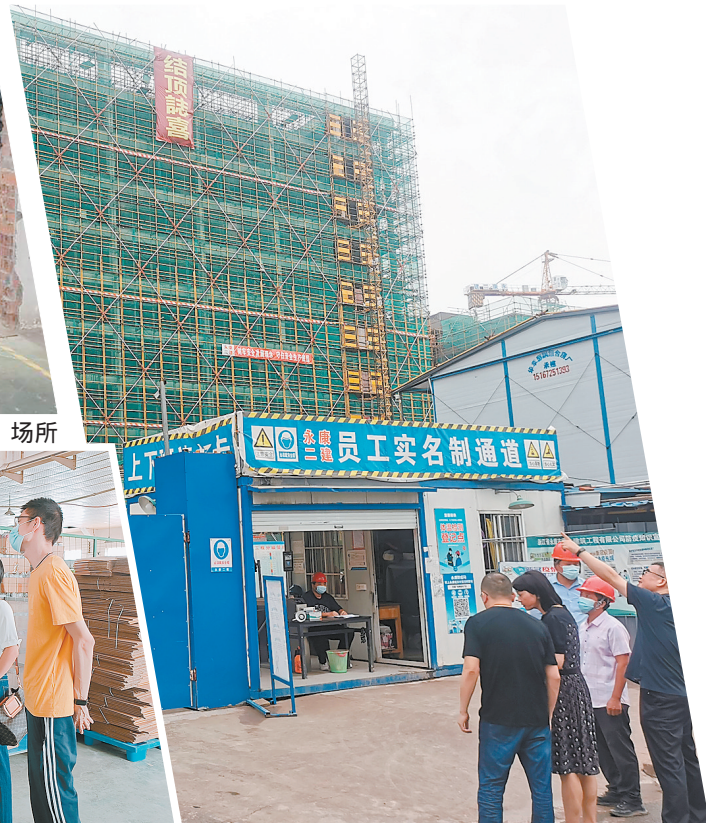
检查建筑工地
