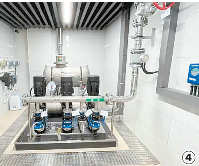
③④三马路公租房二次供水设施改造前后对比，让越来越多的居民饮用水从“供上水”到“供好水”。
