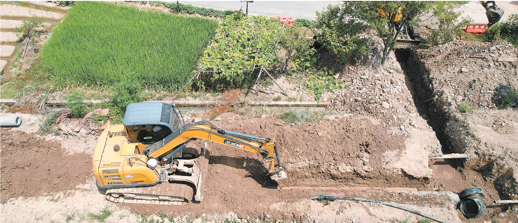
南部水库联网供水工程施工
