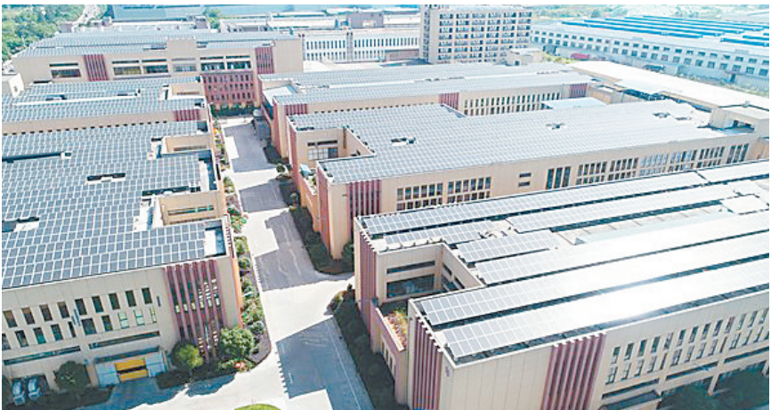
道明公司厂区屋顶都铺设了太阳能光伏发电板
