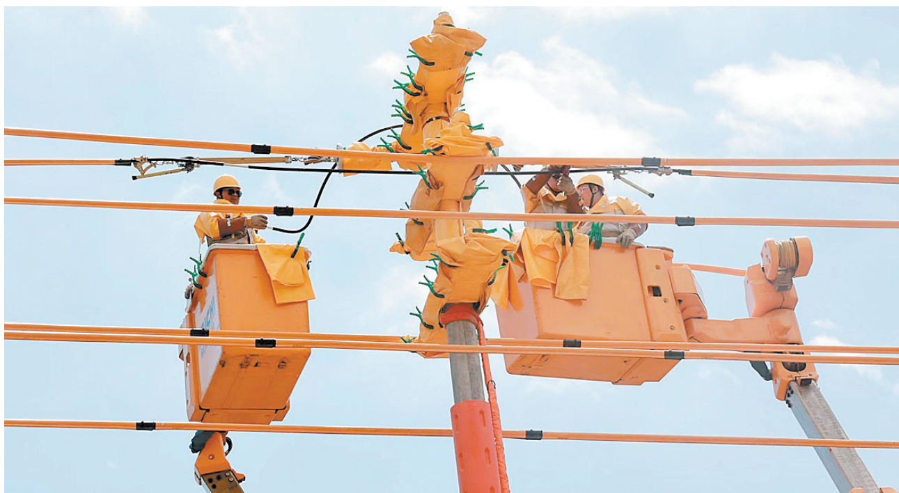
电力工人在高温炙烤下带电作业
