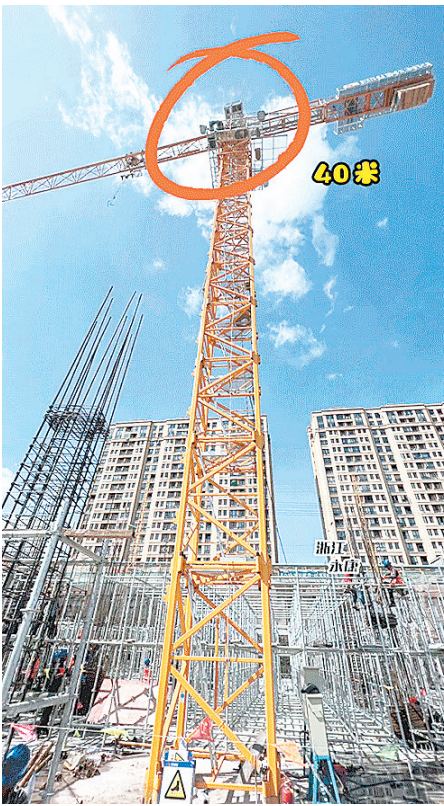
高达40米的塔吊
