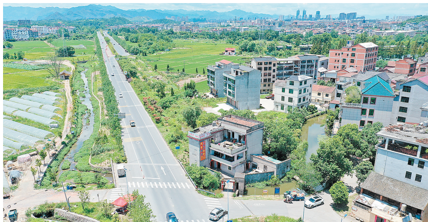
拆除最后一户房屋
