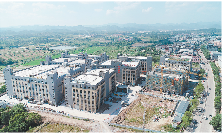
十里牌村 智创园 建设现场
