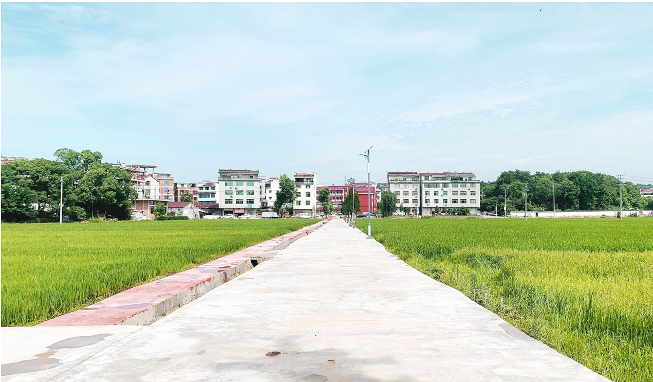
新修水泥路宽敞平整
