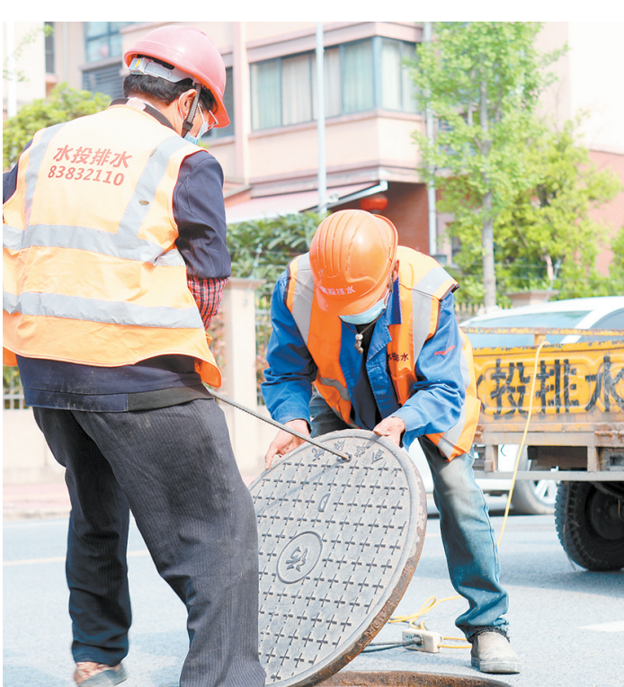
排水公司工作人员正在检查排水设施
