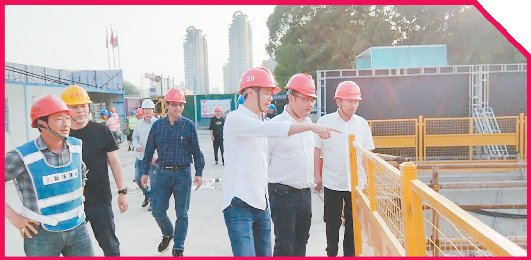
督查建筑工地安全
