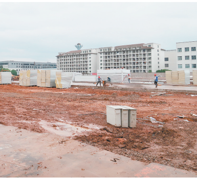
健康驿站施工现场
