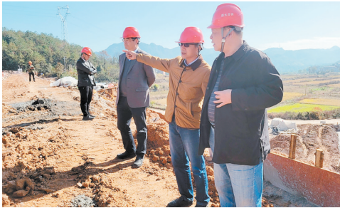
省水利厅领导检查山塘水库除险加固工程
