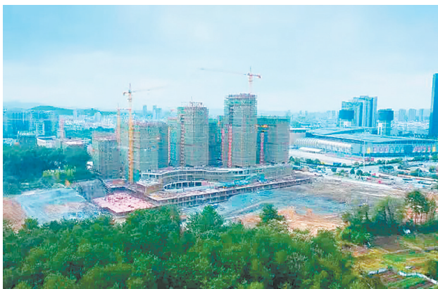
田川未来社区项目建设现场
