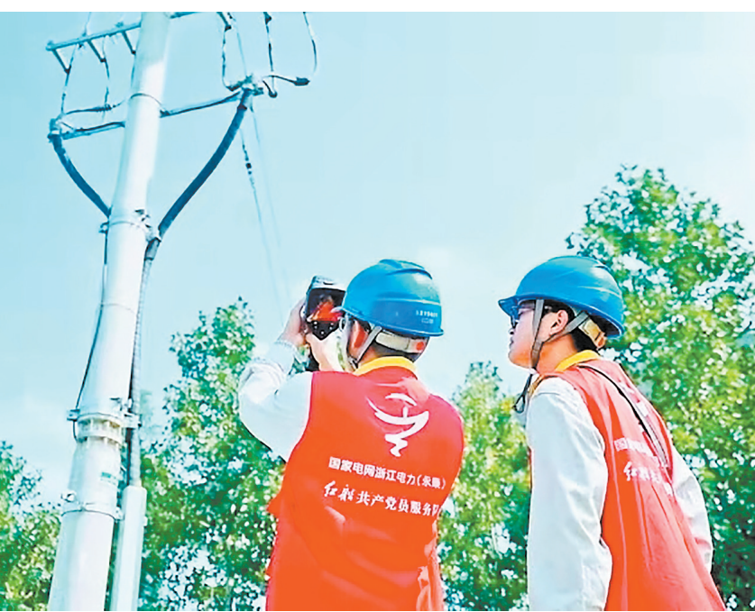
国网永康市供电公司员工在芝英镇检修线路。
