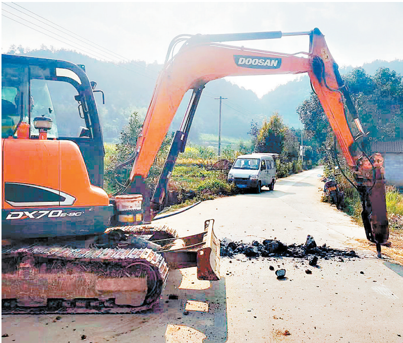
施工人员正在开挖路面，准备安装自来水管网。
