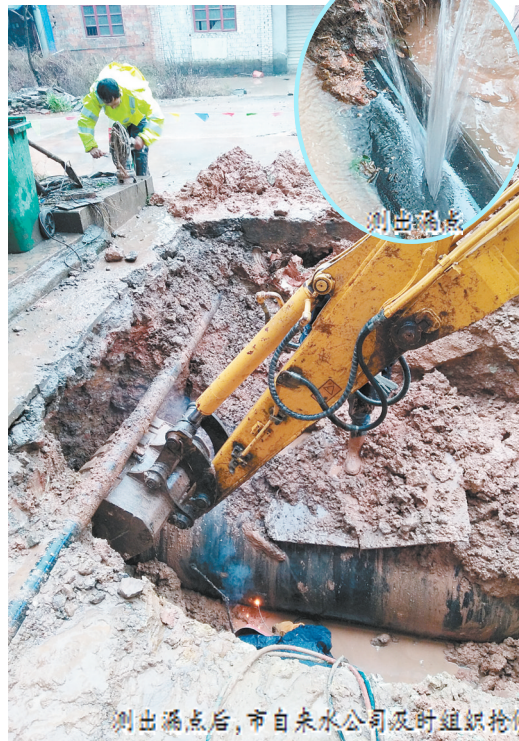
王新毅用测漏仪测漏点
