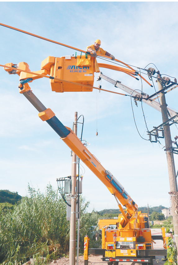
吕康政在为电缆套绝缘管
