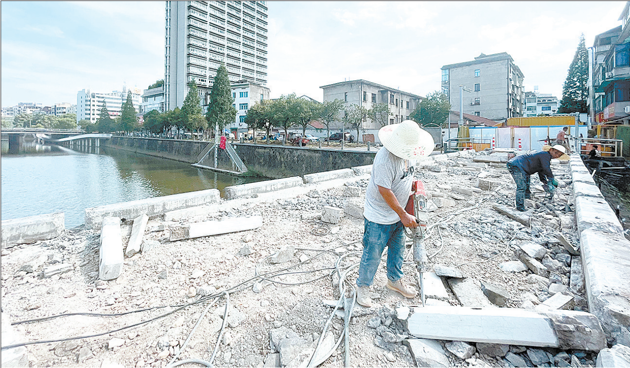
江城桥桥面维修 为了消除安全隐患,方便行人通行,近日,市政管理处启动了江城桥桥面维修工程。工程预计本月底完工。 融媒记者 杨成栋 摄
