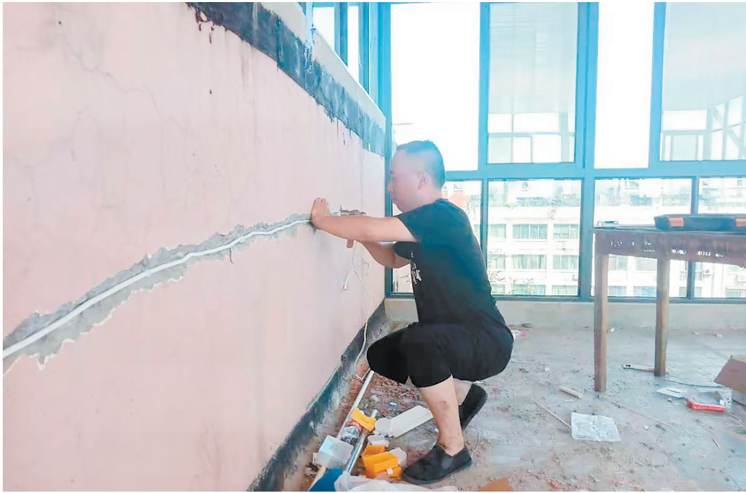
电工凌冲师傅在铺设电线。
