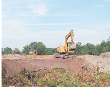
挖机对下谢村区块进行清表作业。
