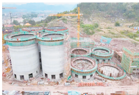
位于象珠镇官川村的永康市粮食储备中心正在建设中
