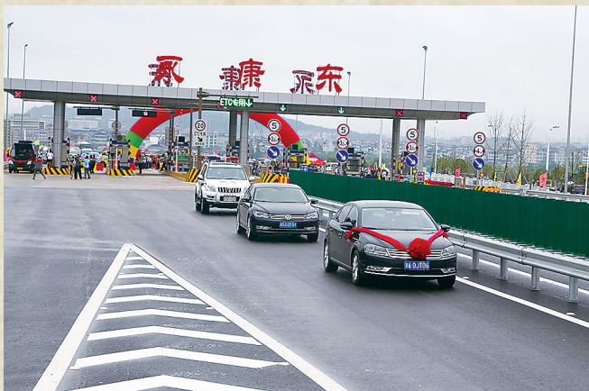
2015年1月25日,连通东阳、永康两地的东永高速公路通过竣工验收。东永高速公路起自东阳马宅,止于丽温高速永康新店枢纽,全长约45公里。
