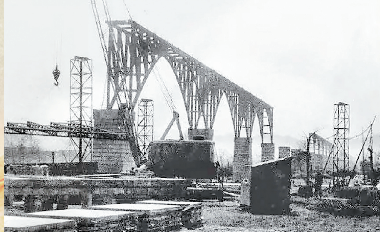
华东地区最长的大渡槽——华东飞渡1987年开工,1991年6月20日通水。华东飞渡是新中国成立后永康在农业设施建设上的最大系统工程。
