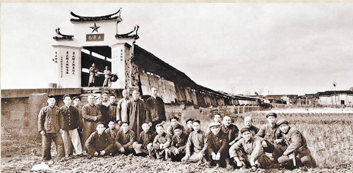
1951年4月7日,解放后西津桥第一次修缮竣工。
