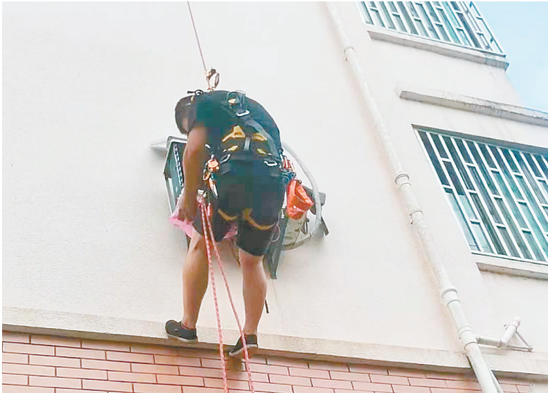
维修师傅在检修空调外机。
