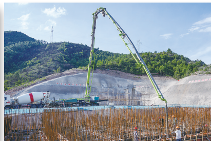
桥下水厂建设工地
