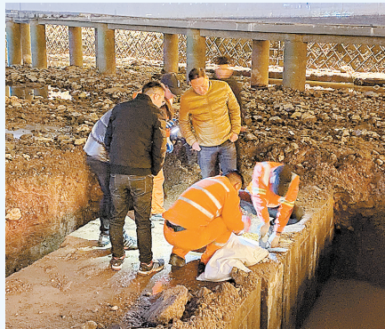
管道开挖修复
