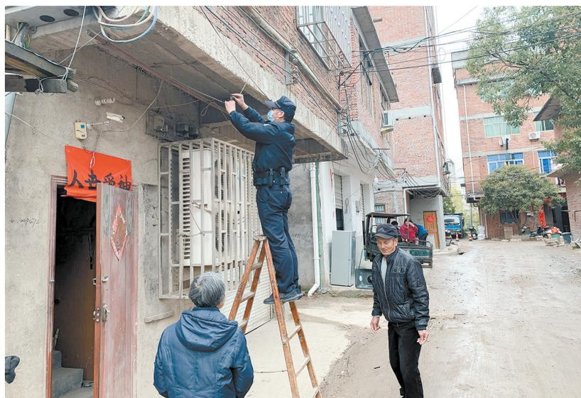
具,站在扶梯上,将监控电线上的杂物清理干净,把电线断开的位置用手钳剥皮重新连接,裹上电胶布,接好后将电线固定在墙上防止再次被风吹断(如图)。
