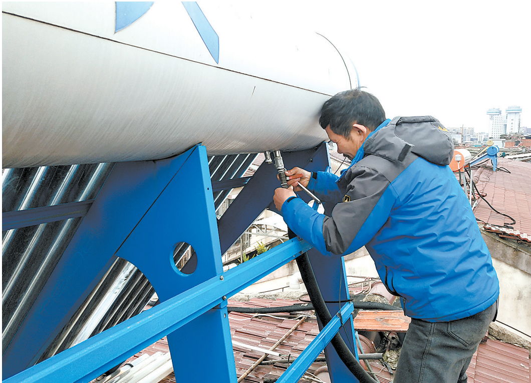
徐师傅在楼顶修理太阳能热水器。
