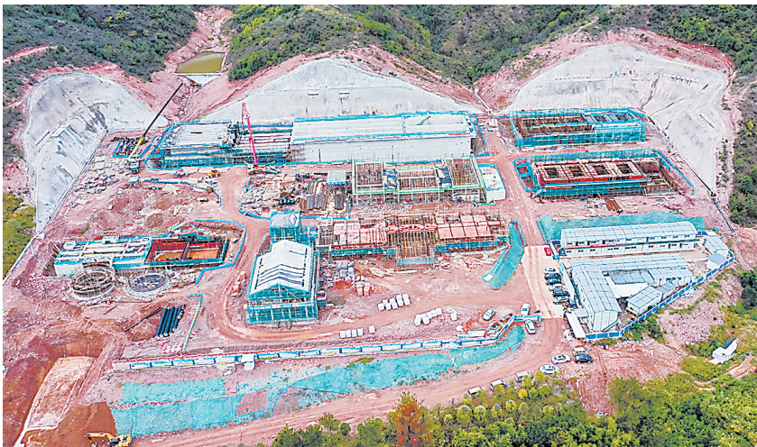
建设中的桥下水厂 通讯员 应敏 摄
