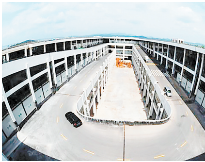
低效厂房改造完成
