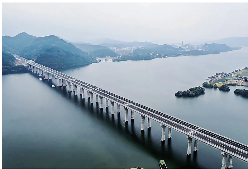
建金高速新安江特大桥一瞥。
