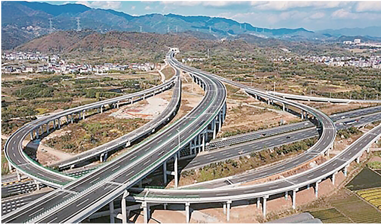
建金高速仙桥东枢纽鸟瞰。
