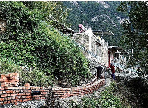
水塘村村民建造灌溉水沟。
